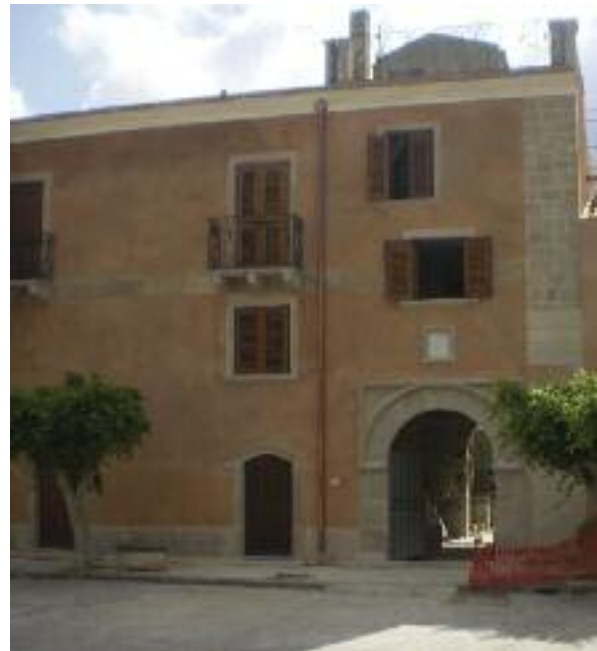
Palazzo Priorale, dopo il restauro
