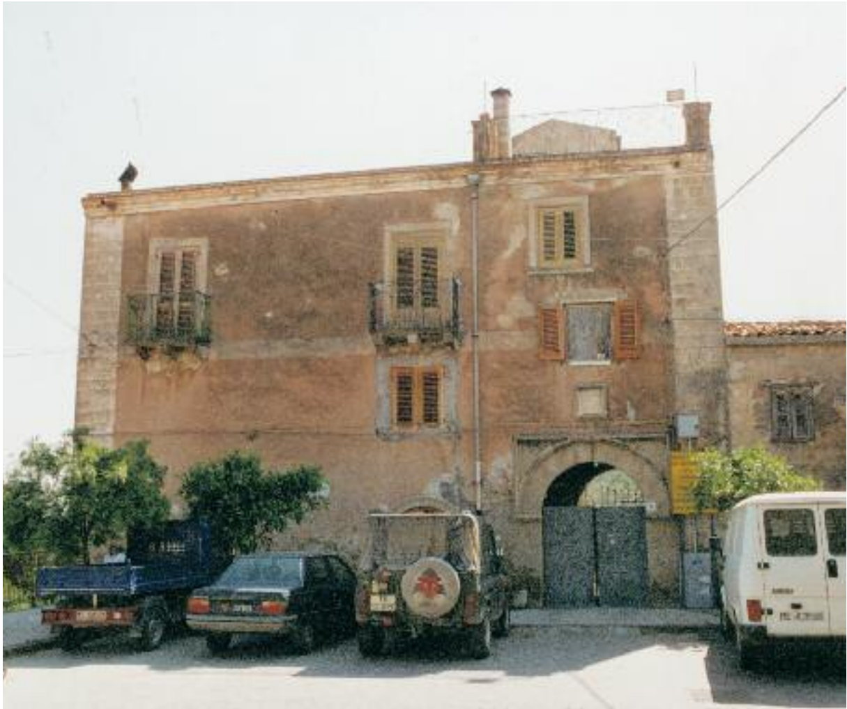
Palazzo Priorale, prima del restauro
